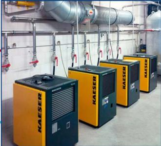
Wärmerückgewinnung der Kompressoren zur Versorgung der Fußbodenheizung und des BC-Controllers (Energieverschiebung)
